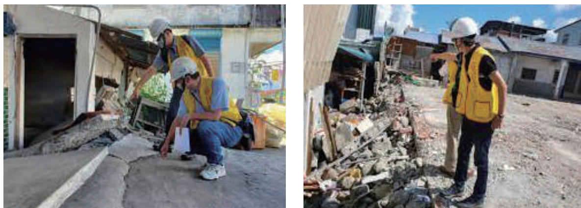
圖 1-19、危險建築物緊急評估作業
